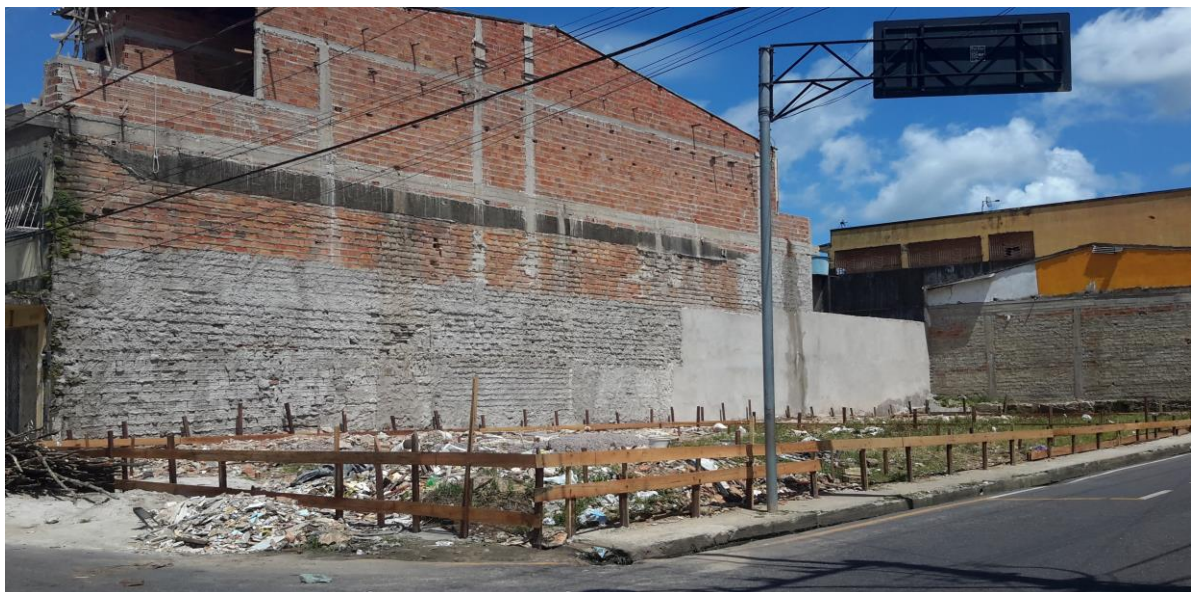
Imagem 11: Ruínas do antigo prédio do Cine Amazônia, 2015. Acervo pessoal
