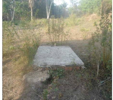
Figura Z: Fossa construída - escola
