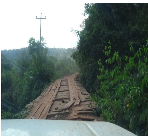
Figura L: Ponte da estrada do Sete.
