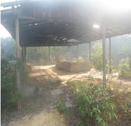
Figura W: Casa de farinha de alvenaria.
