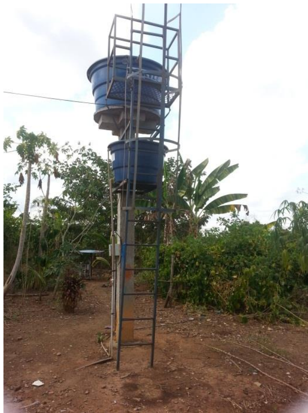
Fig. 37 – Poços instalados para resolver o problema de abastecimento de água.
