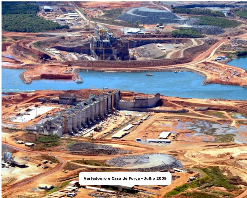
Fig. 03 – vista aérea do vertedouro e casa de força em 2009.
