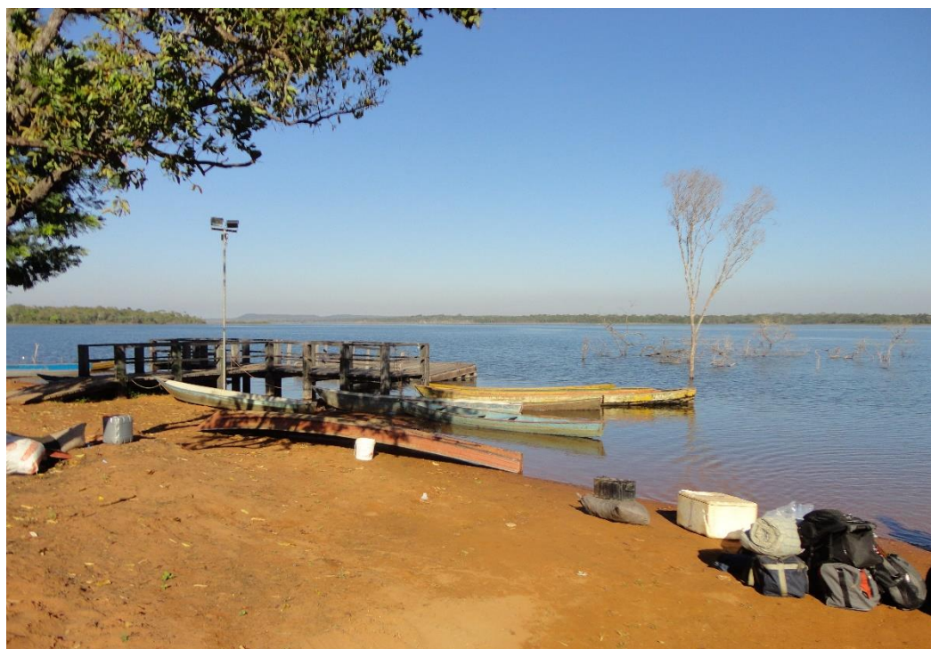
Fig. 42 - O mesmo porto em 2012 já com boa parte tomada pelas águas da barragem.
