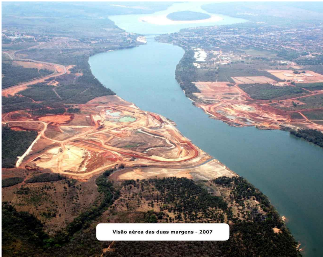
Fig. 01 - vista aérea das duas margens – 2007.
