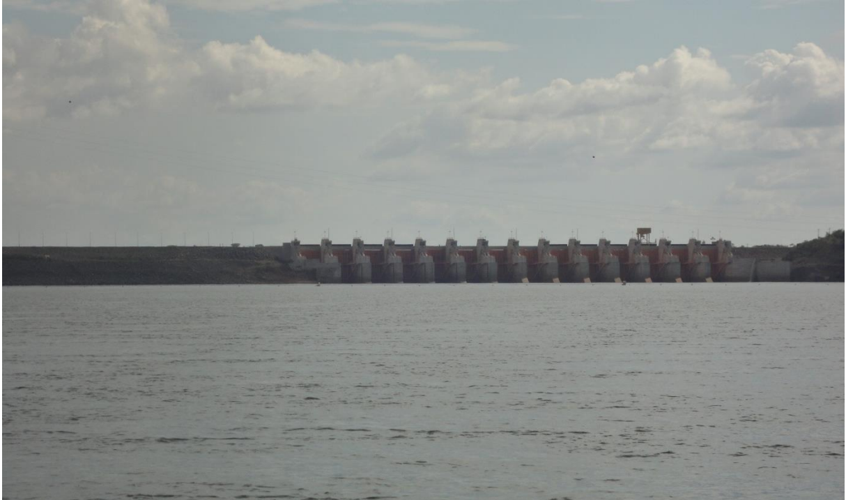
Fig. 04 – Imagem da hidrelétrica de Estreito totalmente construída.
