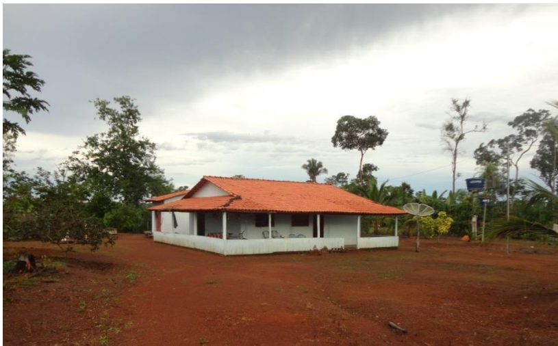
Fig. 39 – Casa de morador ampliada.
